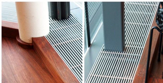
Exempel på vattenskärning och anpassning runt pelare
